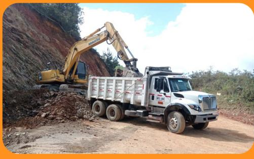
Tramo PR063+0000 – PR073+0000 jurisdicción del municipio de Guaca. En donde se ejecutan actividades como Corte de taludes (1800 m), construcción de filtros (1700m), transporte de material resultante de excavación o corte a sitio de disposición final, construcción de alcantarillas (15 unidades), construcción de box culvert (1 unidad) y construcción de muros de contención tipo I y II (2 muros)
